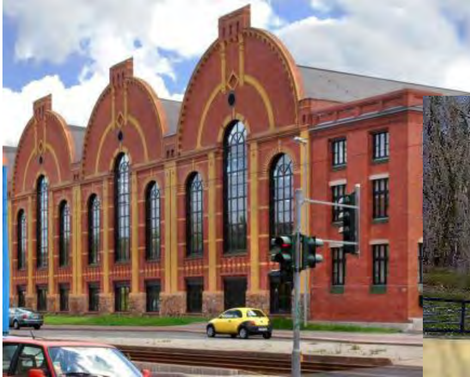
Industriemuseum, in einer ehemalige Werkhalle des Maschinenbaus
