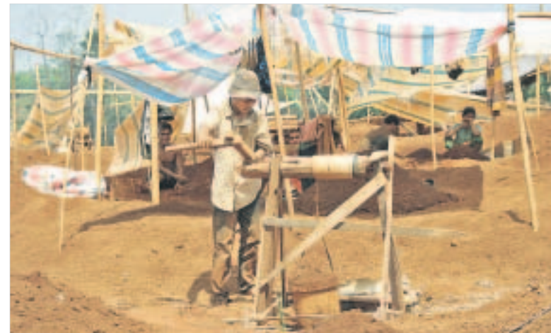
Per Seilwinde wird Zirkon-haltige Erde aus teilweise mehr als zehn Metern Tiefe ans Licht befördert. Planen dienen als Sonnenschutz.
